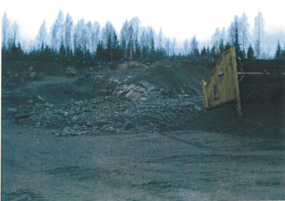
Kuva 1. Kaivualueella 1 kallio on havaittavissa avokalliona.
